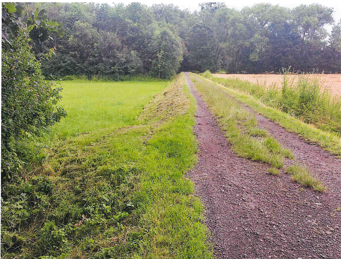
Sjezd v km 1,057 hráze, bez zpevnění
