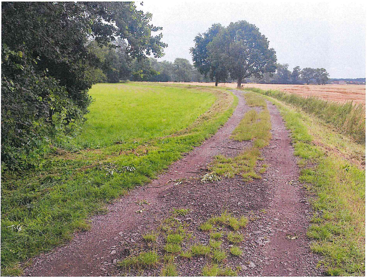
Sjezd v km 1,305 hráze, bez zpevnění
